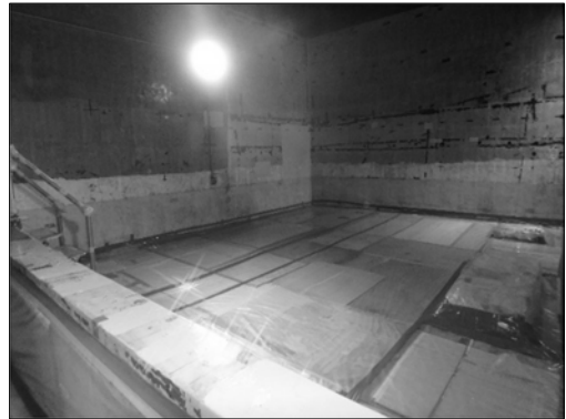
簡易ハウス撤去後
