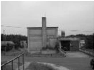
ウラン濃縮研究棟
