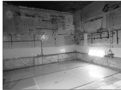
解体用（中和用）GH 撤去後
