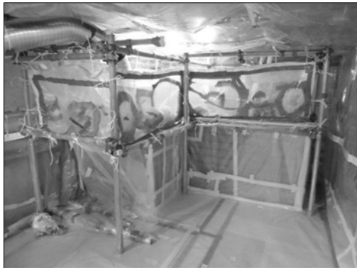
解体用（中和用）GH 撤去前
