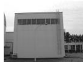
保障措置技術開発 試験室施設 (SGL)
