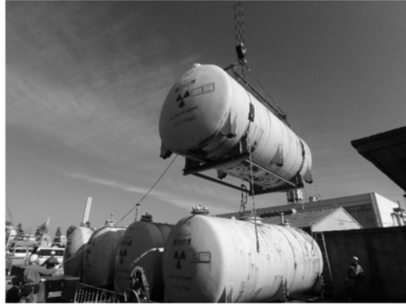
②移動式クレーンを用いての吊り上げ
