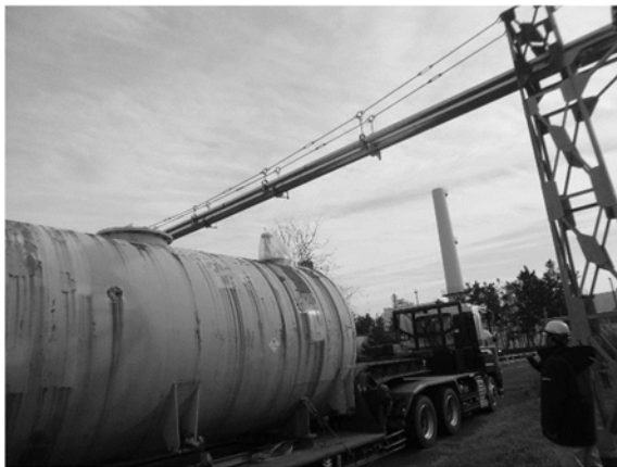
③低床トレーラーでの移送（蒸気配管下）
