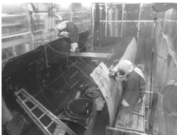
図 3.4.2-3 廃液貯槽の解体処理状況
