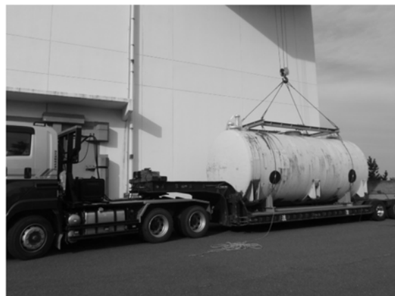
④解体分別保管棟解体室への搬入
